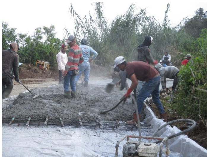
Gambar 8.3 Penghamparan Beton Dengan Tangan
