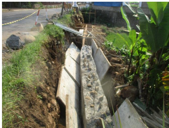
Gambar 8.7 Pemasangan Batu
