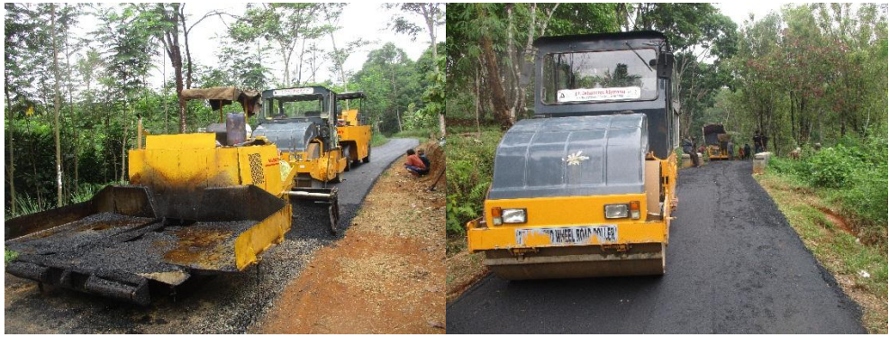
Gambar 8.6 Pemadatan Aspal
