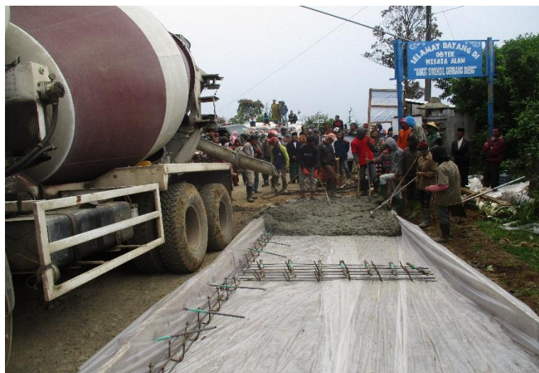
Gambar 8.2 Pengecoran Beton
